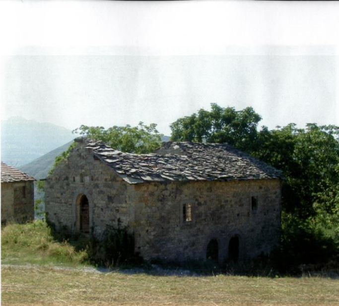
Foresteria prima degli interventi di restauro
