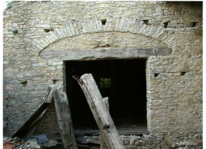
Interno della foresteria prima degli interventi
