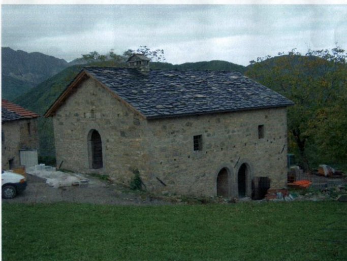
Foresteria dopo gli interventi di restauro
