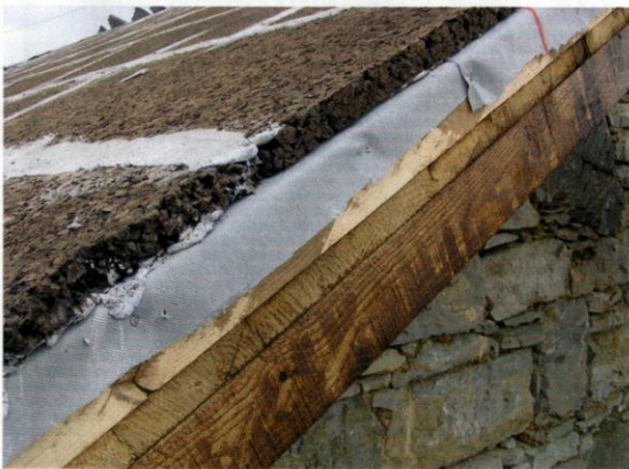
Particolare della copertura (tetto ventilato)
