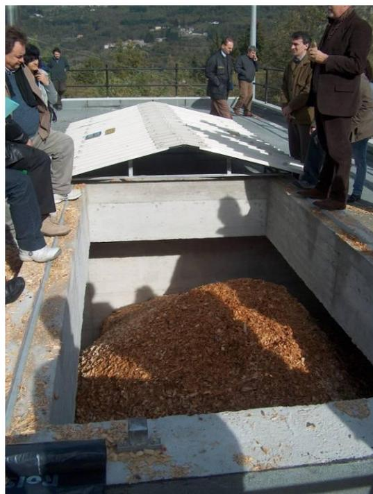
Foto . Il silos del primo impianto di teleriscaldamento a cippato di legna nel Comune di Camporgiano.
